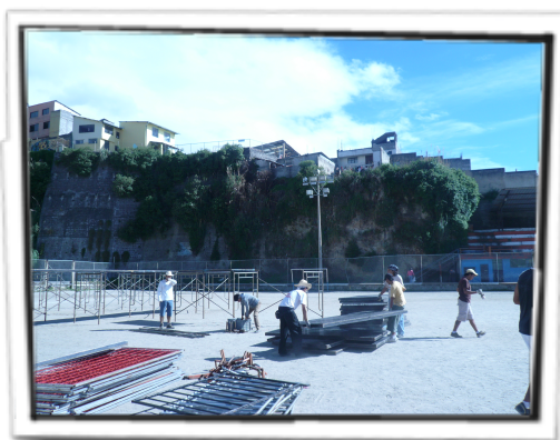
Foto 1: Armado de la tarima.
